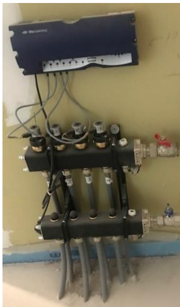
Autotemp regelaar vloerverwarming
